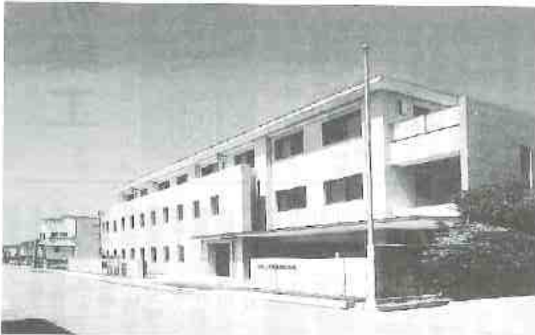
藤井組が施工した京都上労基建築工事
